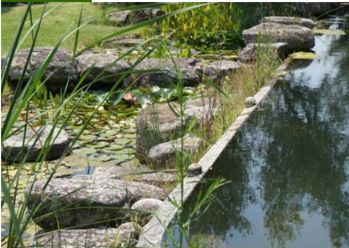
Fig. 7 - Tracimazione dell'acqua dai bordi della vasca centrale a quelle laterali
